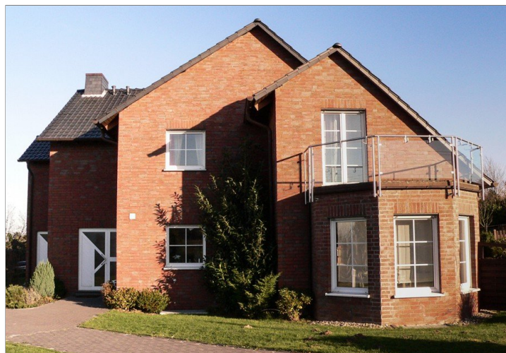
Eingangsbereich Haus 1 und Haus 2
