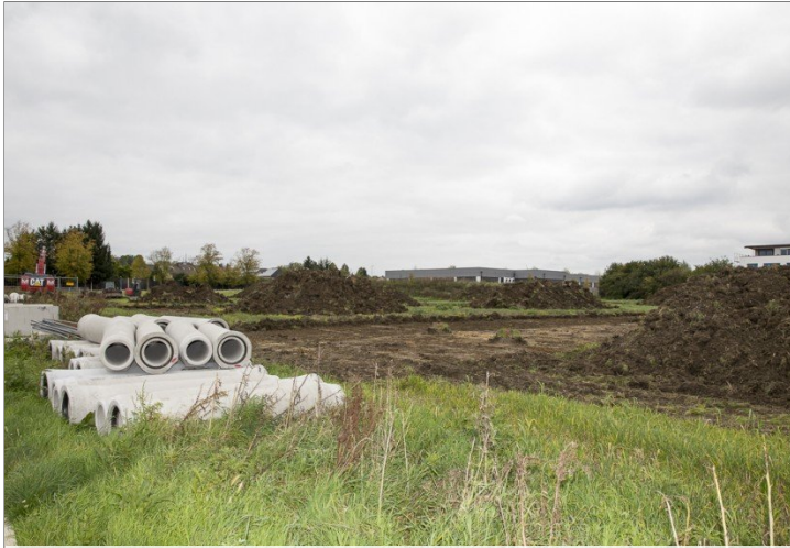
die ersten Rohre für die Kanalisation
