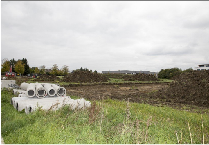
die ersten Rohre für die Kanalisation
