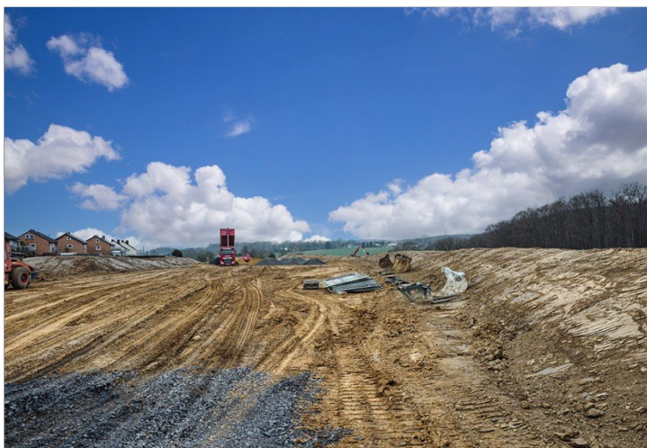
Fleißige Mitarbeiter sorgen für die fachgerechte Erschließung
