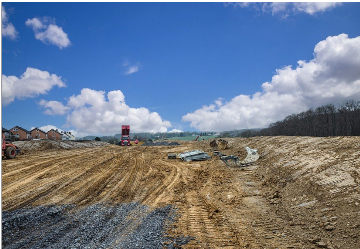
Erschließungsarbeiten sind in vollem Gange - Auf dem Buhrlande in Fröndenberg
