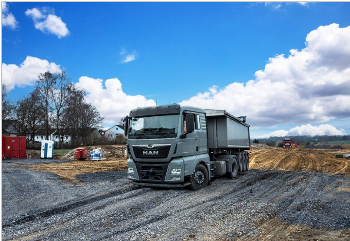
Erschließung des Neubaugebietes Auf dem Buhrlande in Ardey
