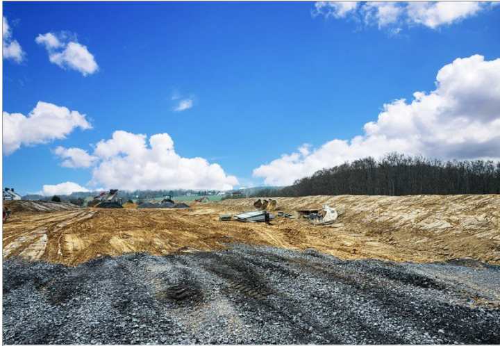
Fleißige Hände sorgen für eine zügige Erschließung Auf dem Buhrlande
