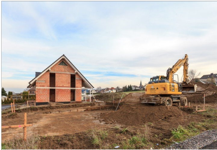
der erste Rohbau steht
