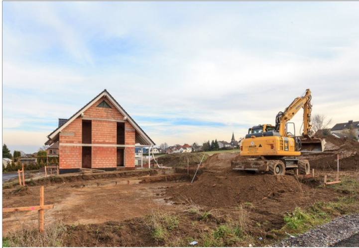
der erste Rohbau steht
