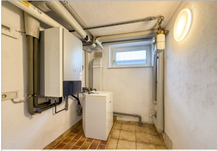
Heizungsraum-Gasheizung-Fabr. Wolf
