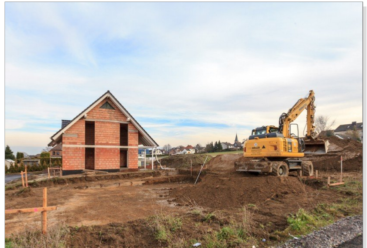
der erste Rohbau steht
