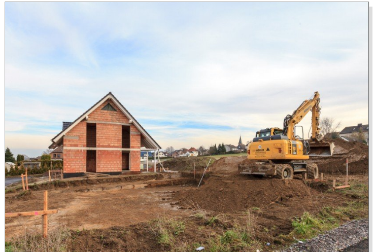
der erste Rohbau steht
