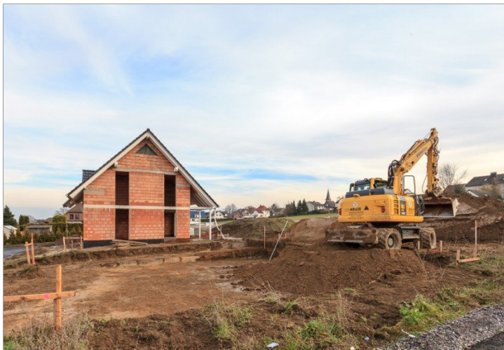
der erste Rohbau steht
